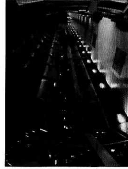
Hospital Metropolitano - Puente Peatonal Avenida Mariana de Jesús
