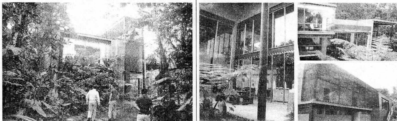
Foto N°3 Elevación posterior del hotel
