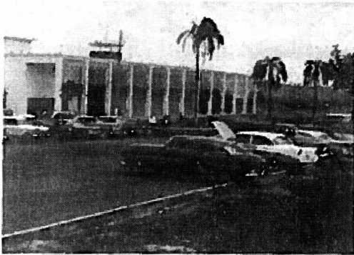
Fotografías de la Terminal Aérea Original, año 1960
