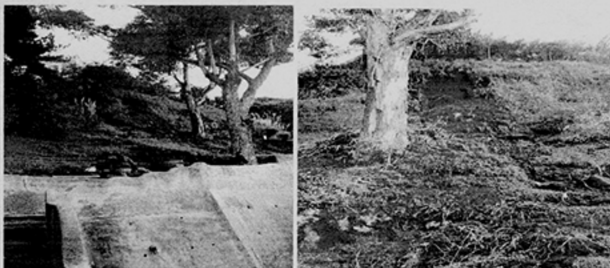
DESLIZAMIENTO DE TALUD
