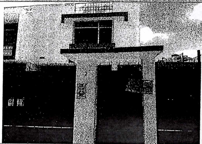
IMAGEN No. 1: Fachada principal del establecimiento "DONAS MARY" visto desde la calle El Universo..
