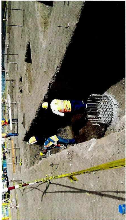
Fundición de Replantillos
