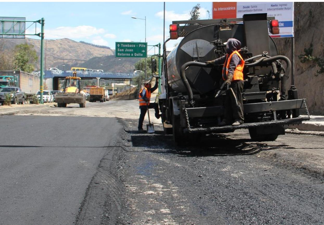
2. Suministro y distribución de material bituminoso sobre la superficie de un pavimento, a fin de conseguir adherencia entre este pavimento.
