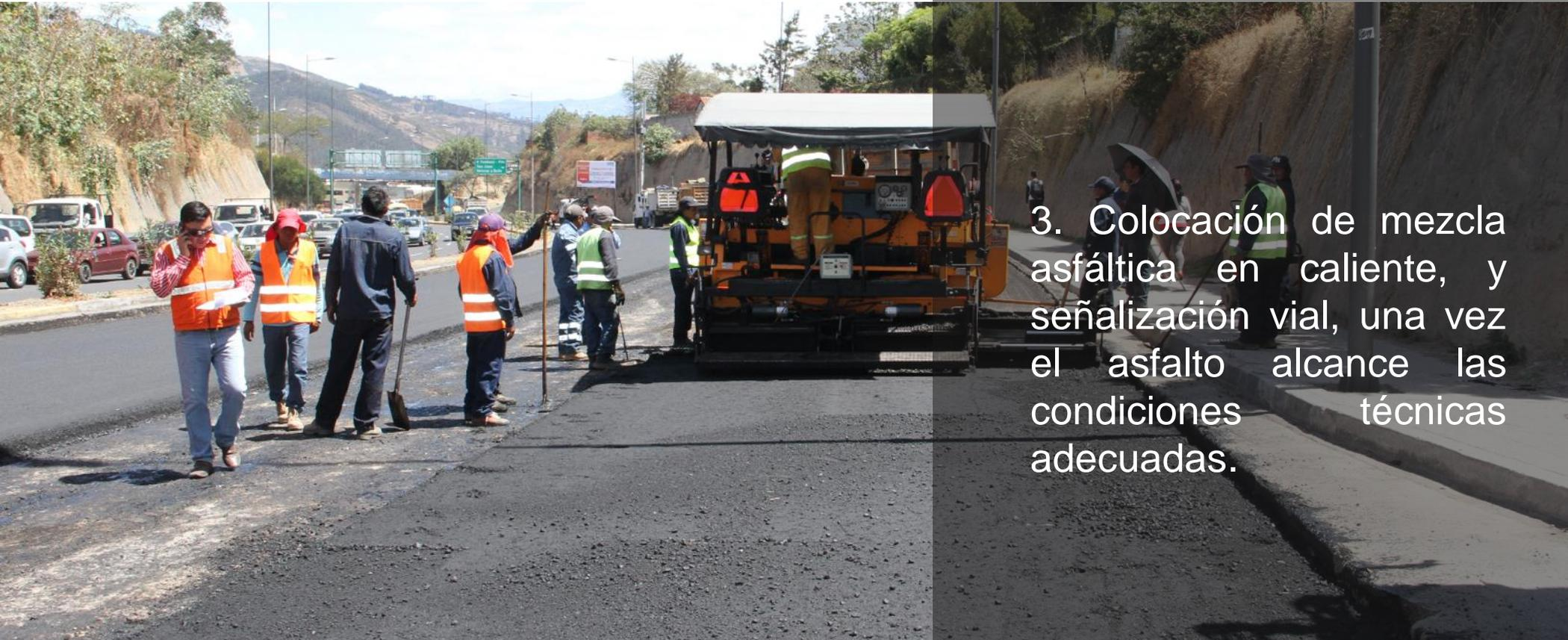
3. Colocación de mezcla asfáltica en caliente, y señalización vial, una vez el asfalto alcance las condiciones técnicas adecuadas.
