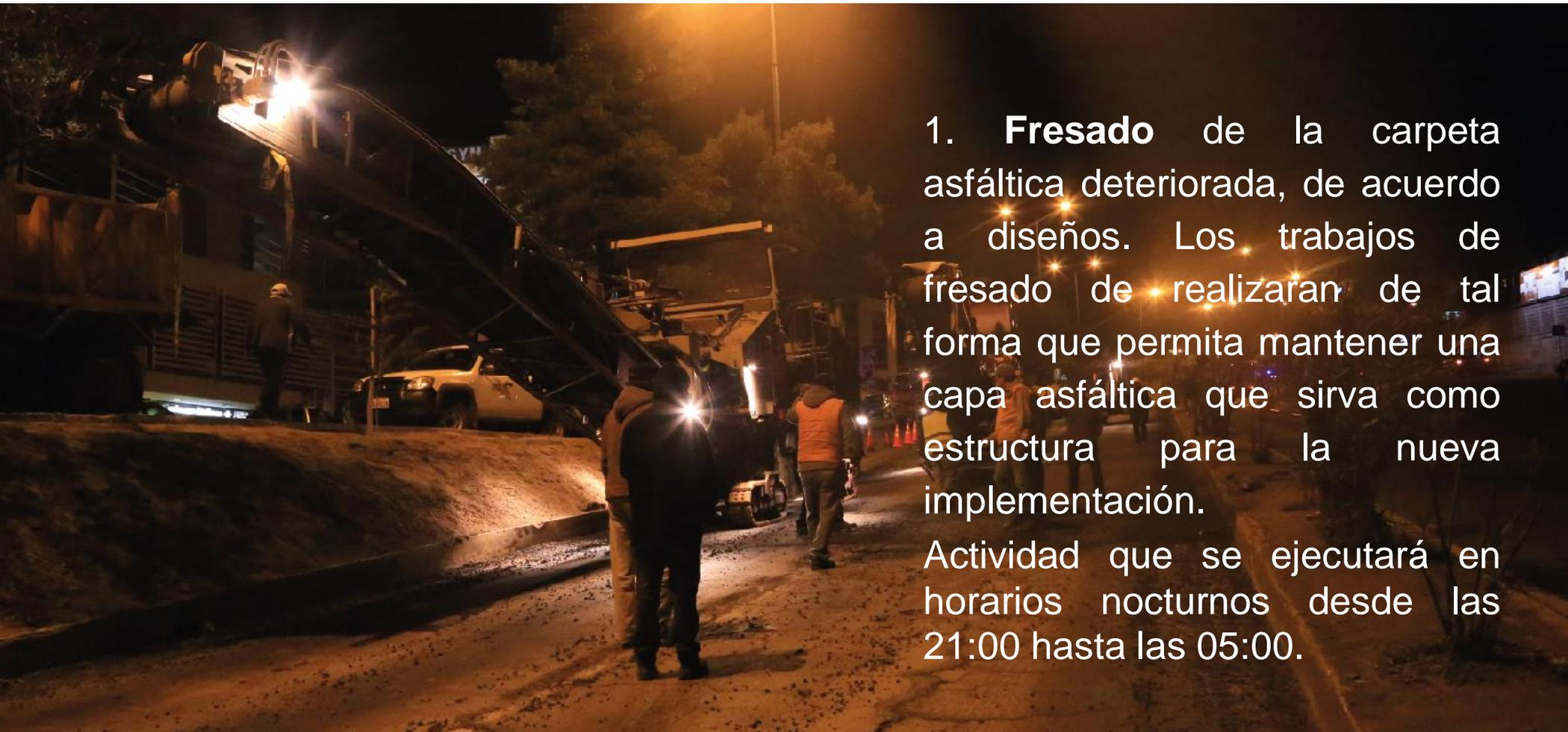
1. **Fresado** de la carpeta asfáltica deteriorada, de acuerdo a diseños. Los trabajos de fresado se realizarán de tal forma que permita mantener una capa asfáltica que sirva como estructura para la nueva implementación.
