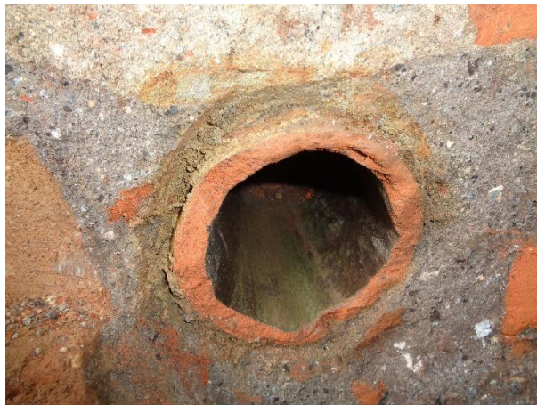
Foto 48 Unidad 2 Tubería de cerámica, detalle constructivo
