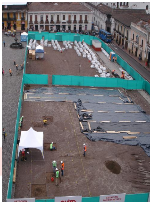
Foto 1. Unidad 1, trazado de unidad e inicio de excavación
