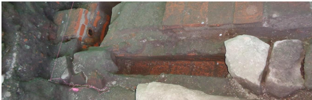
Foto 50 Unidad 2 Ducto cajón cuadrangular tapado con piedras grandes
