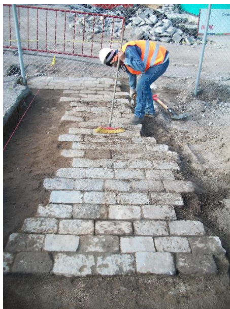
Foto 33 Unidad 7, piso expuesto por excavación
