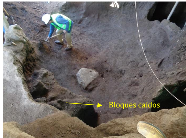
Foto 20 Piedra interior cuarto circular
