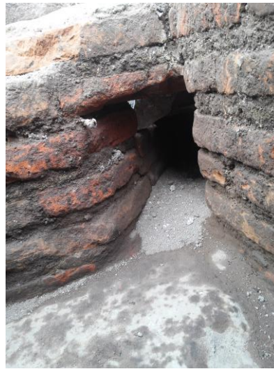
Foto 91 Detalle de unión con caja de sedimentación
