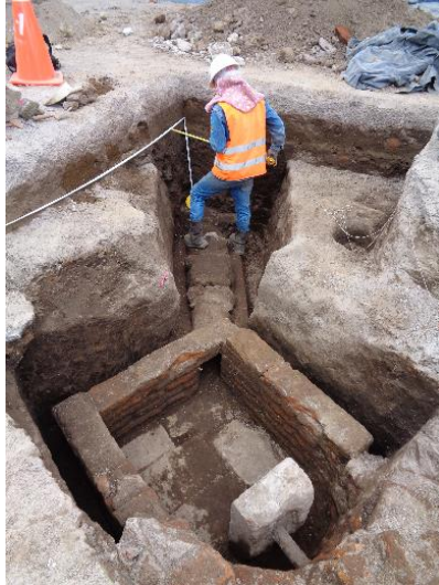
Foto 90 Ducto cajón y Caja de sedimentación
