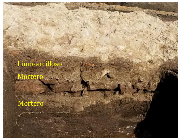
Foto 30 Cimiento de estructura octagonal
