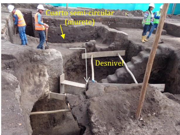
Foto 10. Observese desnivel de cámara 1 y murete en lado occidental de escaleras
