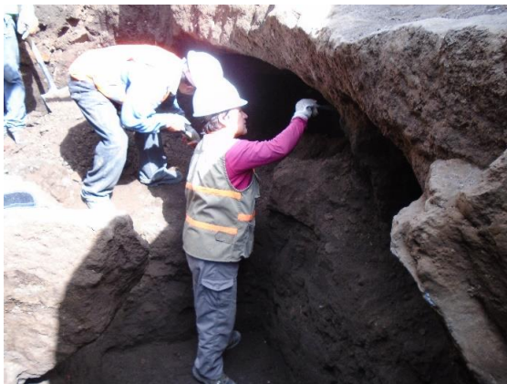
Foto 6. Segundo arco de acceso a bóveda, nótese que no existe la parte superior del mismo.
