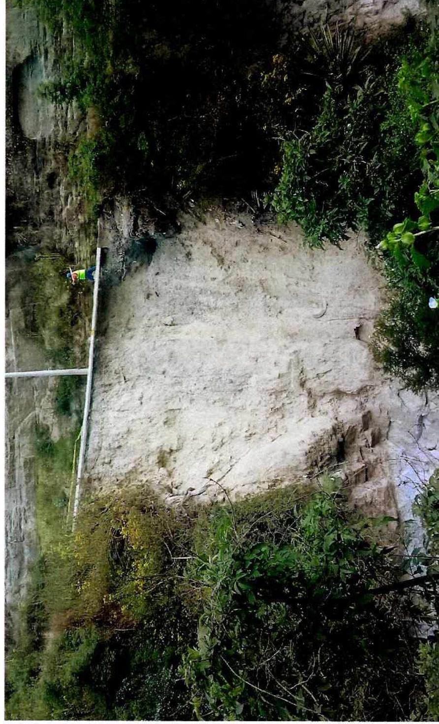
Afectación de talud y mesa de la vía, por fuertes precipitaciones, efectos eólicos y presencia de suelo no consolidado.
