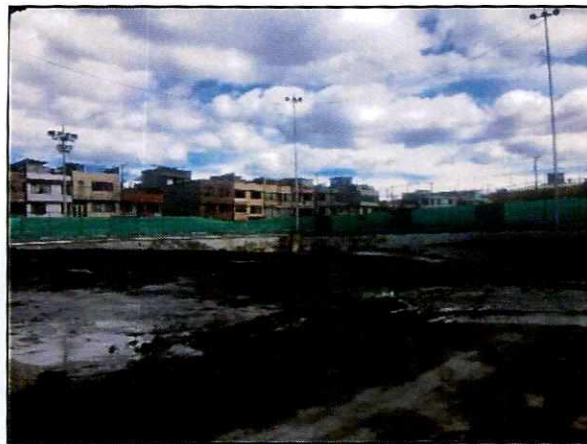
Ilustración 2. Material de excavación, Estación Solanda
