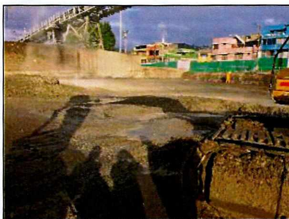
Ilustración 3 Material de excavación, Estación Solanda
