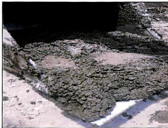
Ilustración 3 Material de excavación, Estación Solanda
