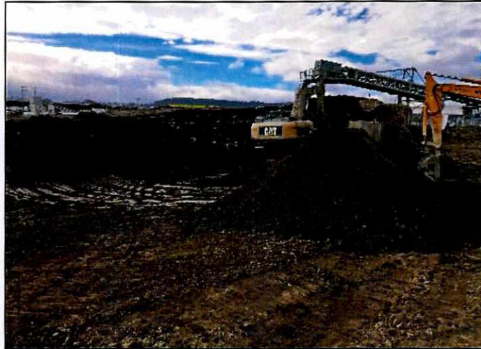
Ilustración 1. Material de excavación, Estación El Labrador
