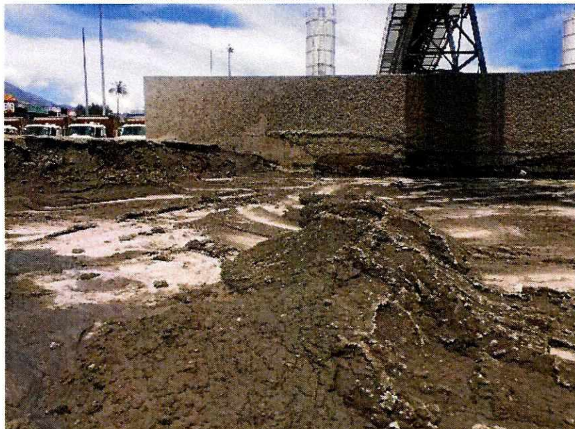
Material de excavación. Estación Solanda
