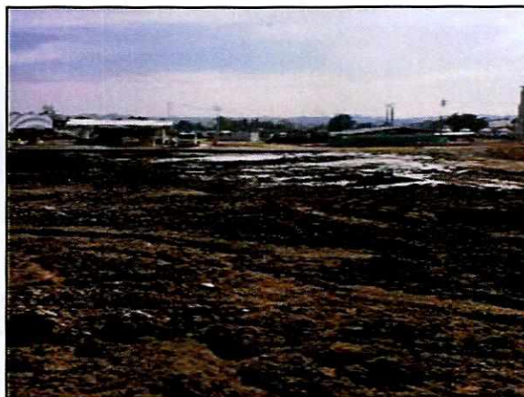
Ilustración 2 Material de excavación, Estación El Labrador
