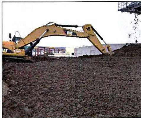
Ilustración 1. Material de excavación, Estación El Labrador
