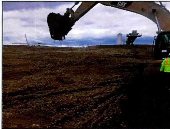
Ilustración 2 Material de excavación, Estación El Labrador
