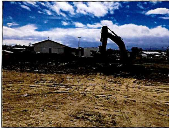
Ilustración 1. Material de excavación, Estación El Labrador
