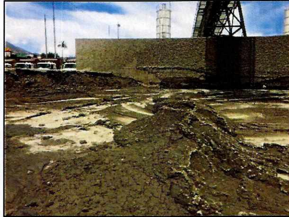
Ilustración 2 Material de excavación, Estación Solanda
