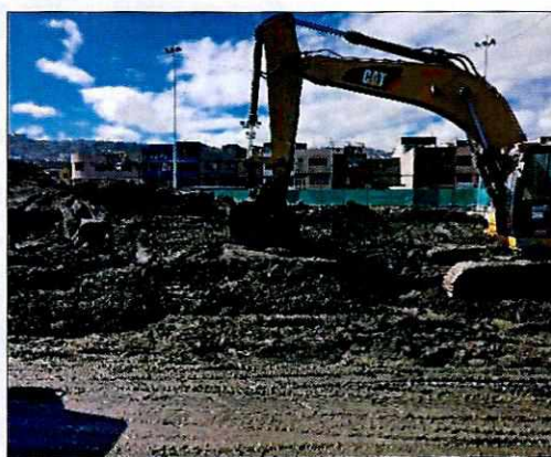
Ilustración 2. Material de excavación, Estación Solanda
