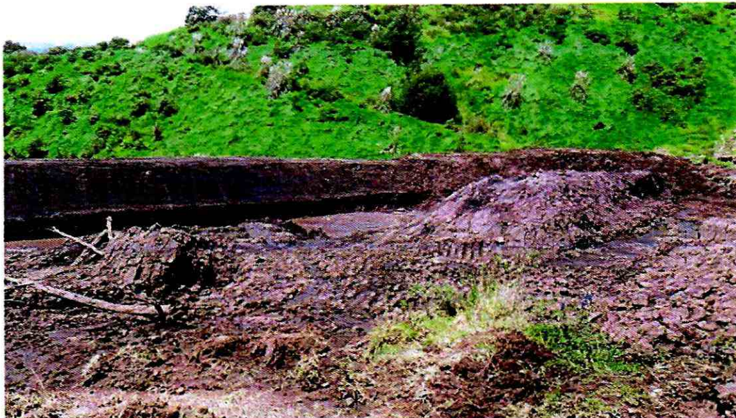
CONSTRUCCIÓN DE DIQUE DE CONTENCIÓN Y CUBETO
