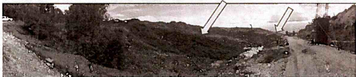
Bermas para estabilización del talud y construcción de colector para manejo de aguas superficiales provenientes de la Av. Simón Bolívar.
