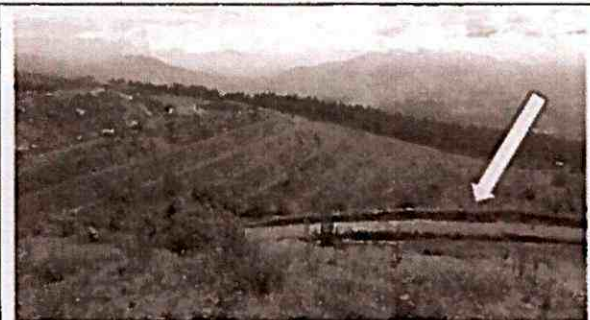
Bermas para estabilización del talud y construcción de colector para manejo de aguas superficiales provenientes de la Av. Simón Bolívar.
