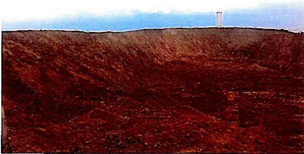
CONSTRUCCIÓN CUBETO Y DIQUE LINDERO SUR
