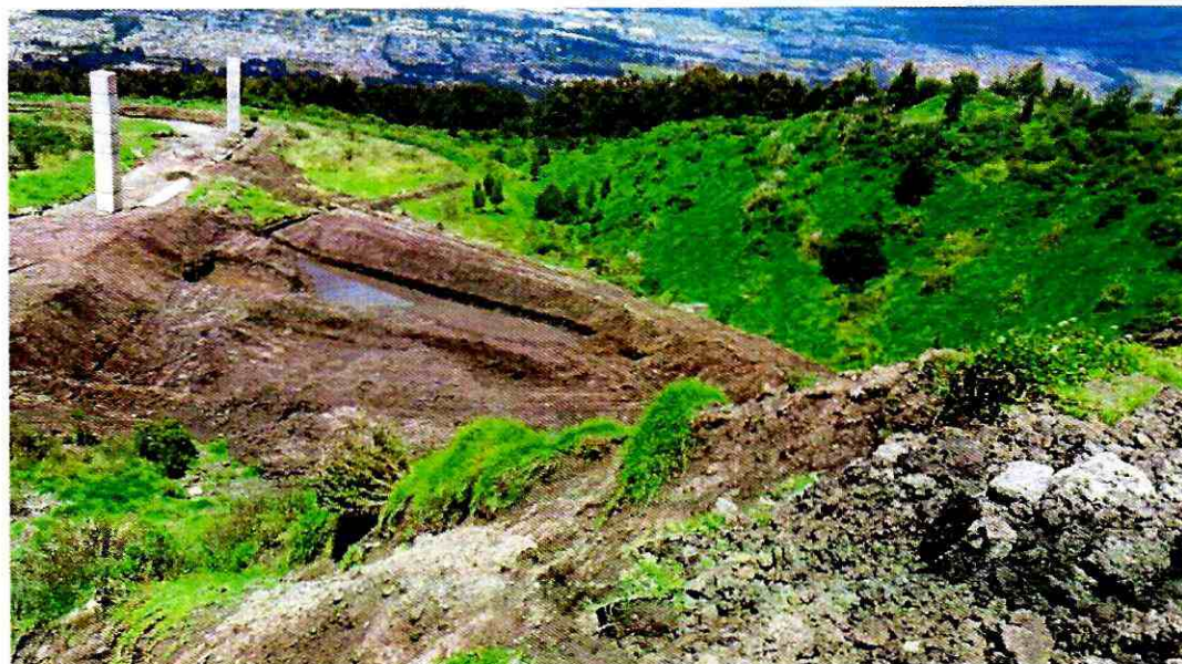
CUBETO CONSTRUIDO PARA RECEPCIÓN DE LODOS DEL METRO.
