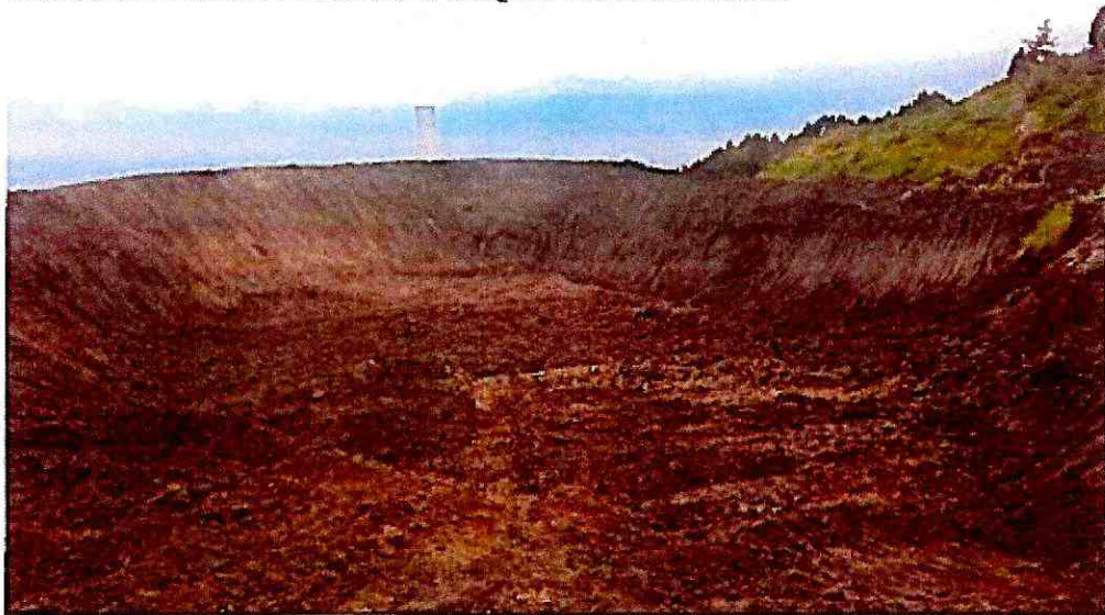
CONSTRUCCIÓN CUBETO Y DIQUE DE CONTENCIÓN PARA CONTENER DESLIZAMIENTO TROJE 3
