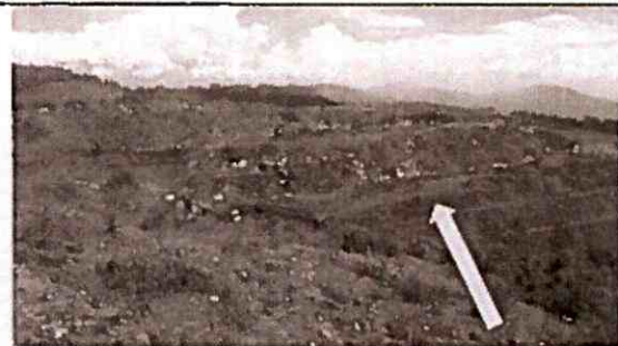
Bermas para estabilización del talud y construcción de colector para manejo de aguas superficiales provenientes de la Av. Simón Bolívar.
