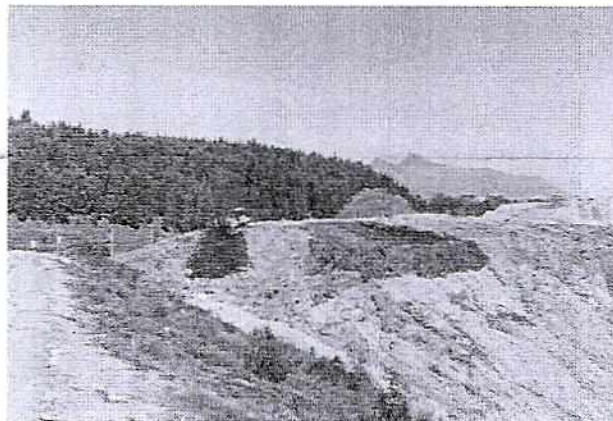
Foto 1: Aplanando plataforma sur para mejorar tendido de material
