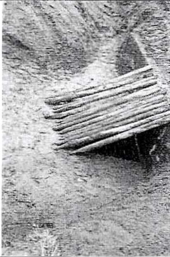
Foto 3: Canales para aguas lluvia
