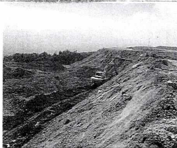
Foto 4: Se inician trabajos en la zona superior de la escombrera para evitar nuevos deslizamientos
