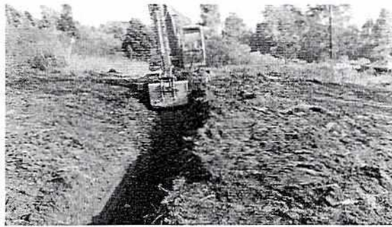
Foto 2: Construcción de cunetas
