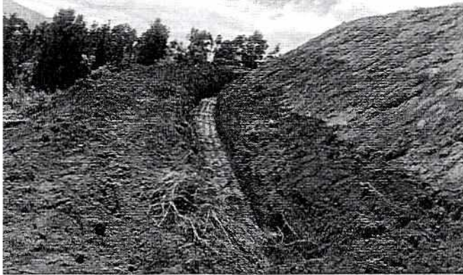
Foto 1: Construcción de cunetas
