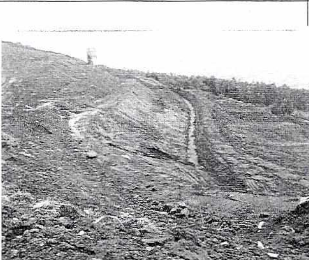
Foto 3: Canales para aguas lluvia
