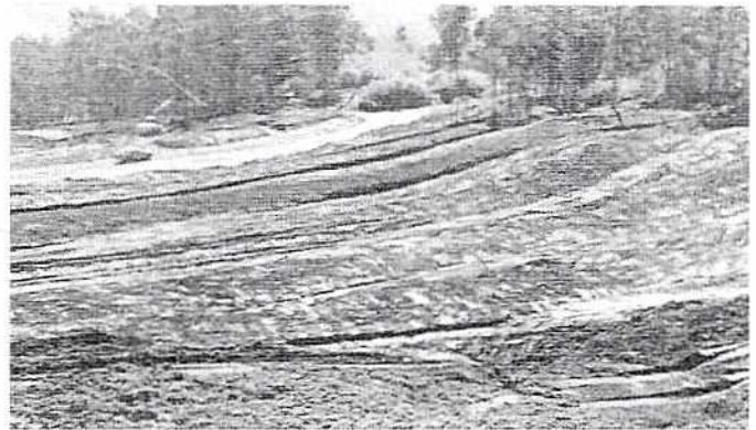
Foto 4: Conformación de plataformas en contra pendiente sector Norte.
