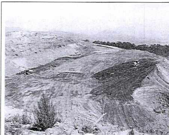
Foto 5: Trabajos en la plataforma 2
