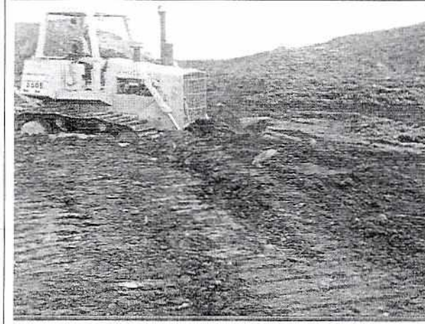
Foto 3: Conformación de dique para soporte extra
