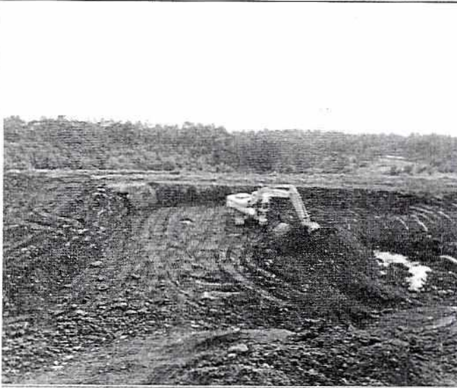
Foto 3: Continúan los trabajos en la zona superior de la escombrera para evitar nuevos deslizamientos
