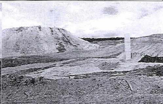
Foto 8: Avance de trabajos
