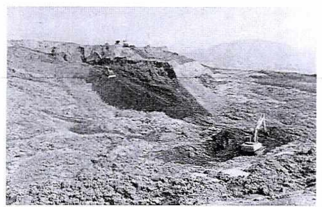
Foto 2: Tendido de material seco, para conformación de dique en la parte alta
