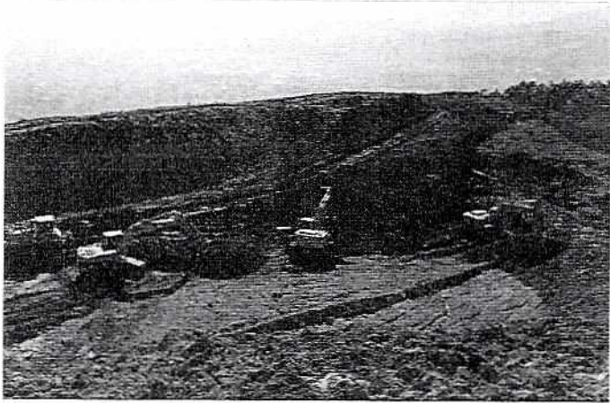
Foto 3: Tendido de material (Simón Bolívar)
