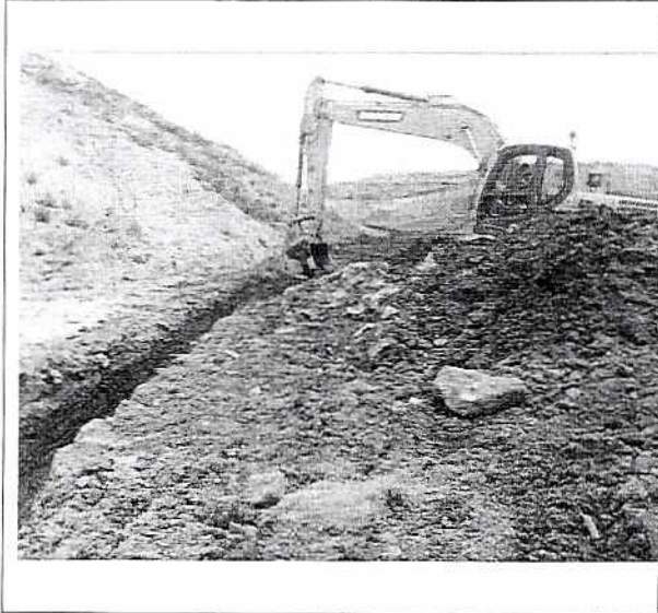
Foto 3: Conformación de dique para soporte extra
