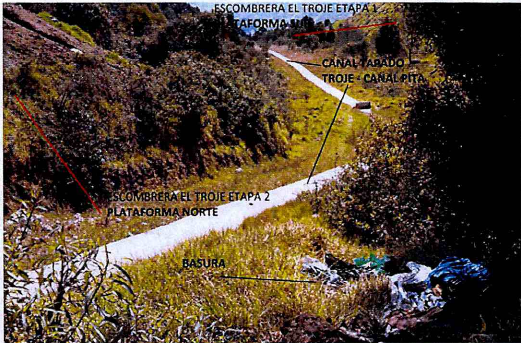
Gráfico No. 3 Escombrera "El Troje" en sus Etapas 1 y 2 y obras de infraestructura de la EPMAPS
