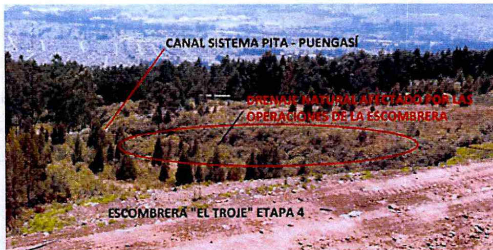
Gráfico No. 6 Drenaje natural afectado por aluviones producidos desde la escombrera El Troje
