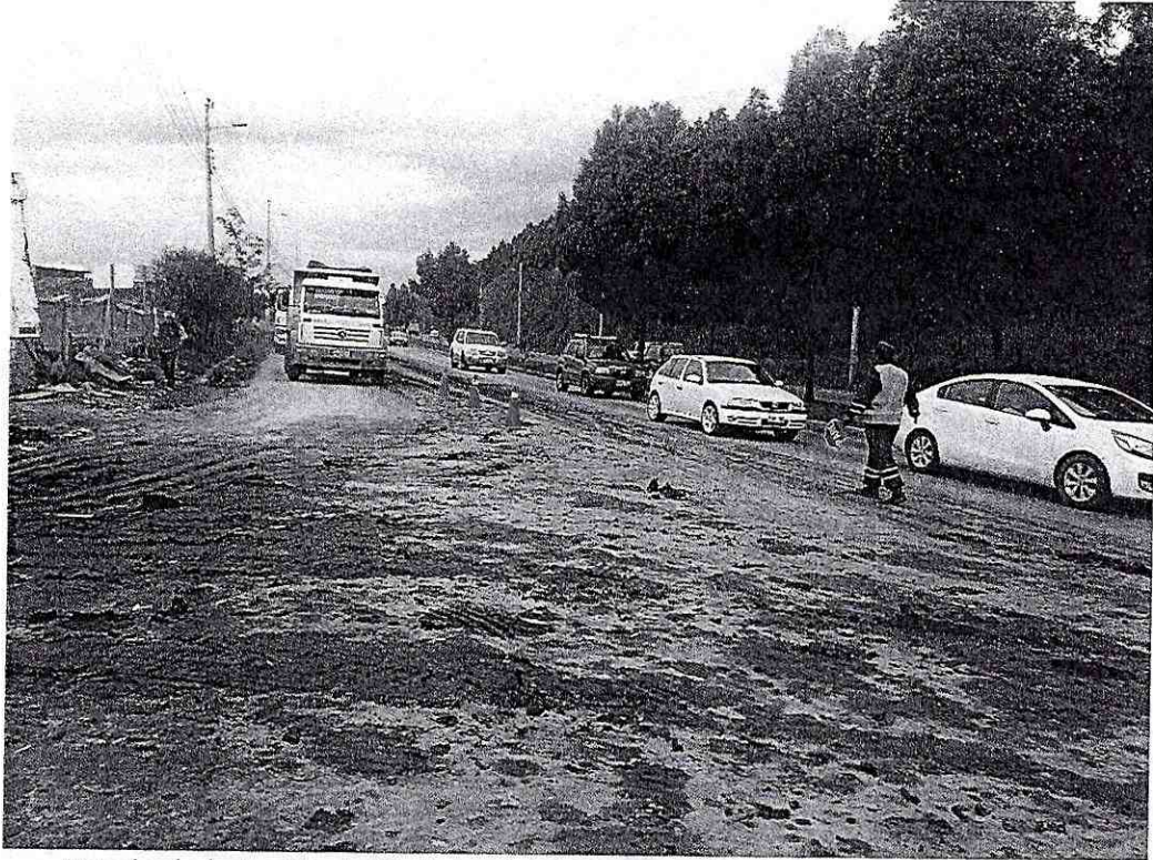
Estado de la Av. Simón Bolívar y la vía de entrada y salida a la escombrera El Troje 4. 20/05/2017
