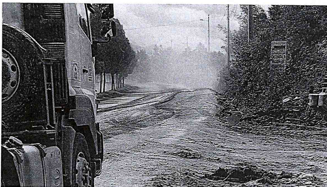
Estado de la vía de entrada y salida a la escombrera El Troje 4. Se aprecia el paso de tanquero pero no es suficiente para evitar generación de polvo. 21/05/2017
