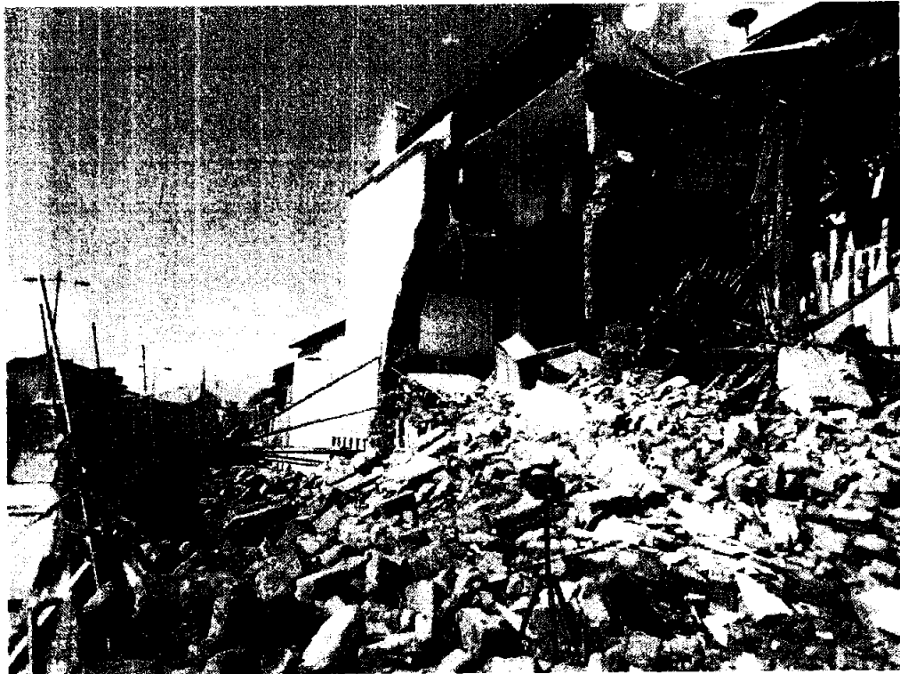
IMAGEN4: VIVIENDA COLAPSADA FUENTE: LOS AUTORES
