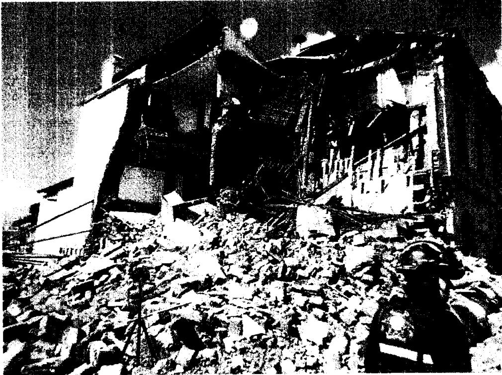
IMAGEN3: VIVIENDA COLAPSADA FUENTE: LOS AUTORES
