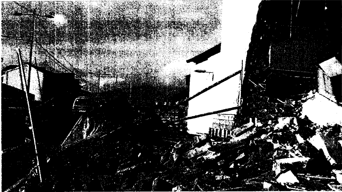
Colapso y apuntalamiento en el fondo
