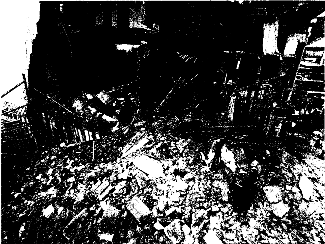
Colapso estructural (colapso suspendido)
