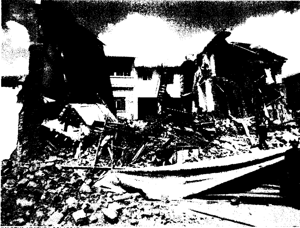
IMAGEN5: VIVIENDA COLAPSADA FUENTE: LOS AUTORES
