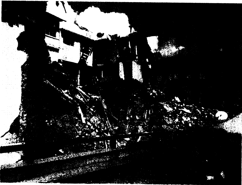
IMAGEN6: VIVIENDA COLAPSADA FUENTE: LOS AUTORES
