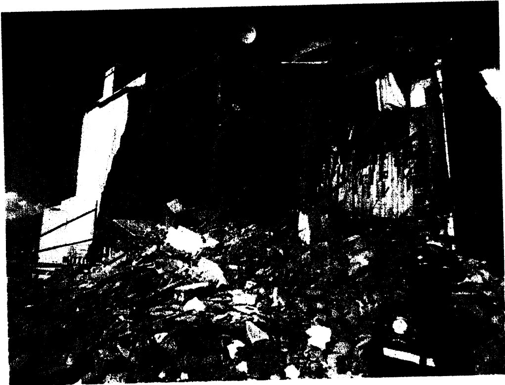
IMAGEN3: VIVIENDA COLAPSADA FUENTE: LOS AUTORES
