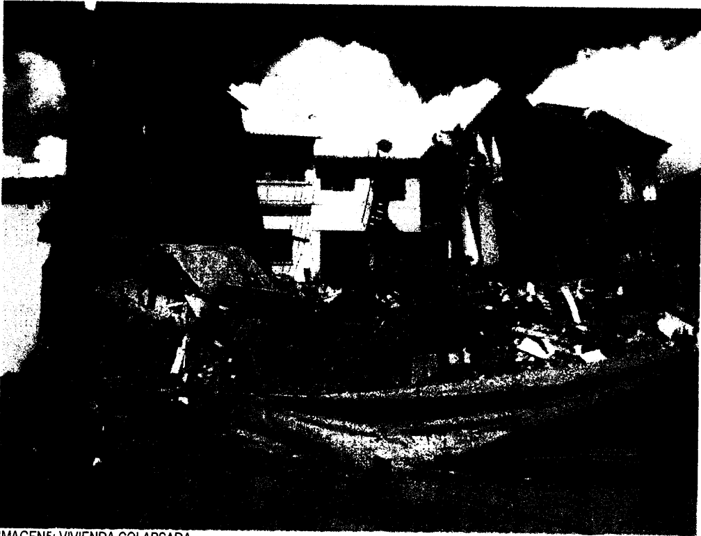
IMAGEN5: VIVIENDA COLAPSADA FUENTE: LOS AUTORES
