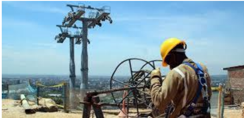
Figura 19 – Construcción de pilonas para el MIO Cable (Cali-Colombia)
