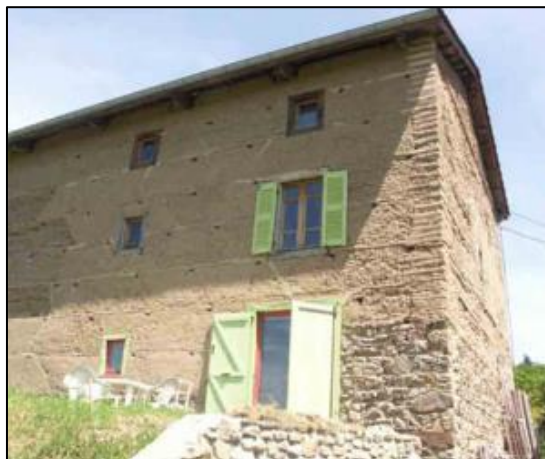
Ilustración 12 Imagen referencial de una edificación con estructura de tapial Fuente: https://tierrah.wordpress.com/author/julierabaud/
