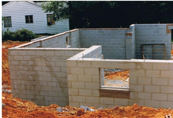
Imagen referencial de una edificación con estructura de bloque Fuente: http://blog.360gradosenconcreto.com/mamposteria-estructural-el-que-y-el-como/
