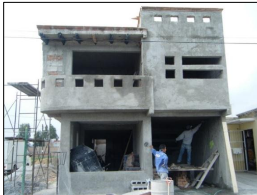
Ilustración 16 Ejemplo de una construcción "en obra gris"
