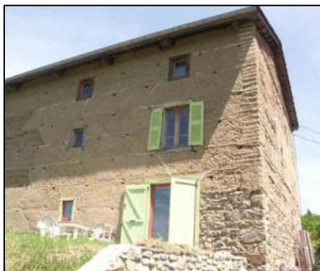
Ilustración 10 Imagen referencial de una edificación con estructura de tapial Fuente: https://tierrah.wordpress.com/author/julierabaud/
