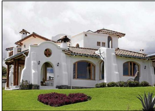
Ilustración 9 Imagen referencial de una edificación con estructura de adobe Fuente: http://icasasecologicas.com/bio-viviendas-la-casa-cueva-moderna/
