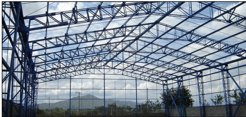
Ilustración 6 Imagen referencial de una edificación con estructura de cercha metálica
