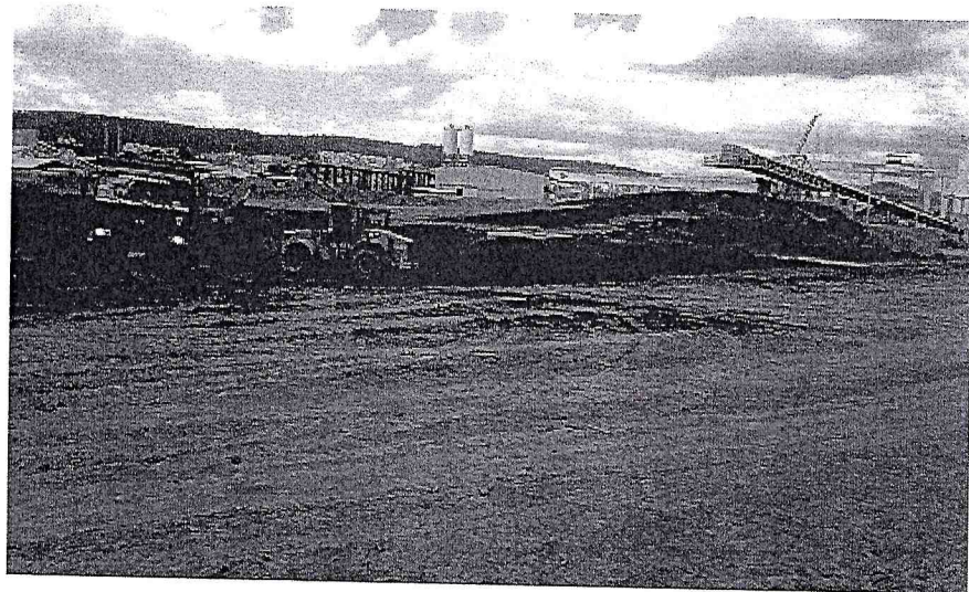
FOTO 3: Carga de material extraído a vertedero.
