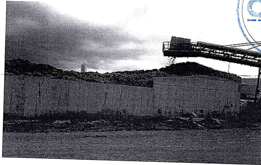
FOTO 4: Acopio de tierras de material excavado en El Labrador.
