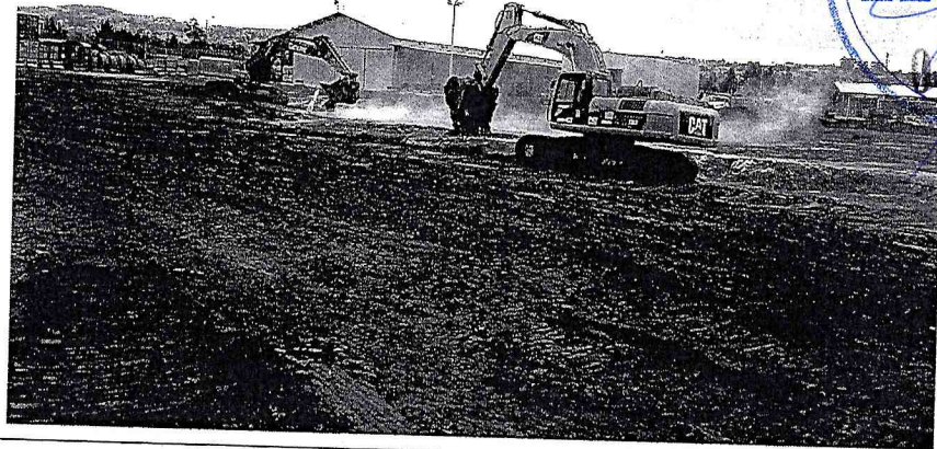
FOTO 4: Adición de cal en zona de carga.
