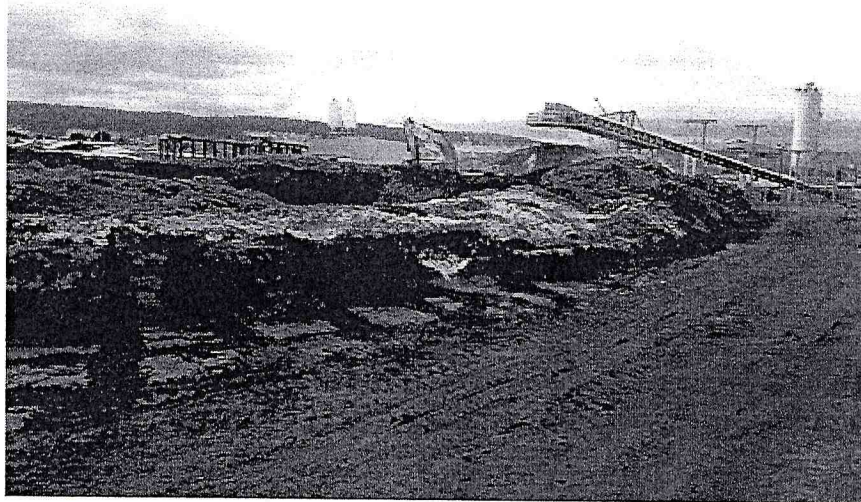
FOTO 2: Colocación directa de cal en el material extraído previo a la carga y transporte.
