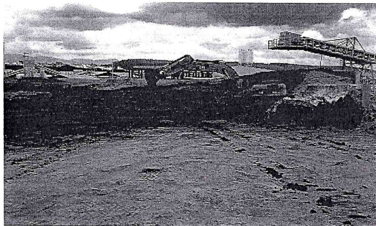
FOTO 3: Zona de carga del material extraído.
