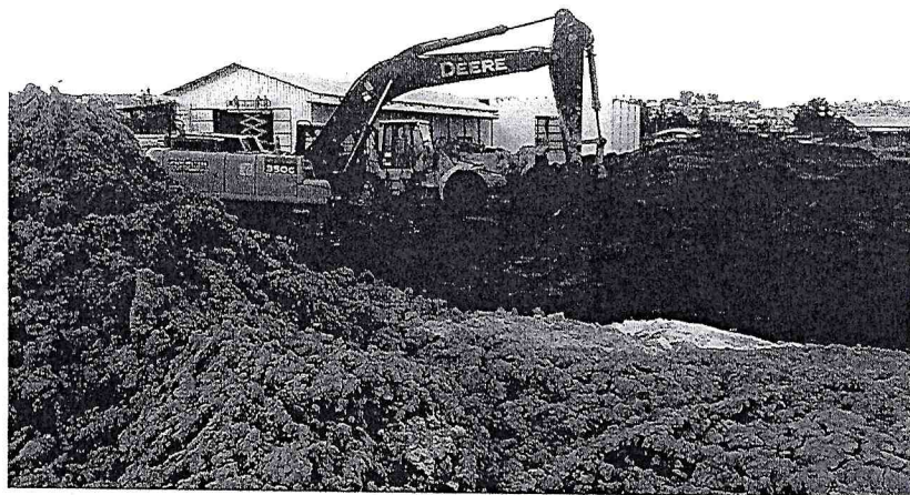
FOTO 3: Adición de cal al material extraído en el acopio de tierras.
