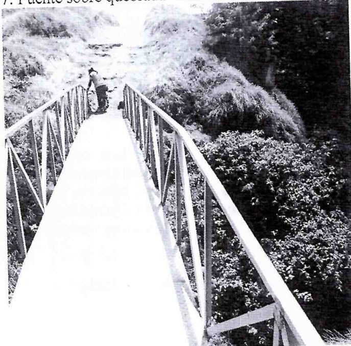
Imagen 7: Puente sobre quebrada "San José de Guamaní" tramo oeste
