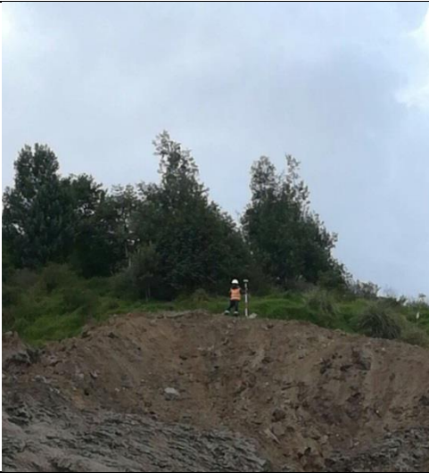
Foto 5: Se inició con el levantamiento topográfico del área afectada
