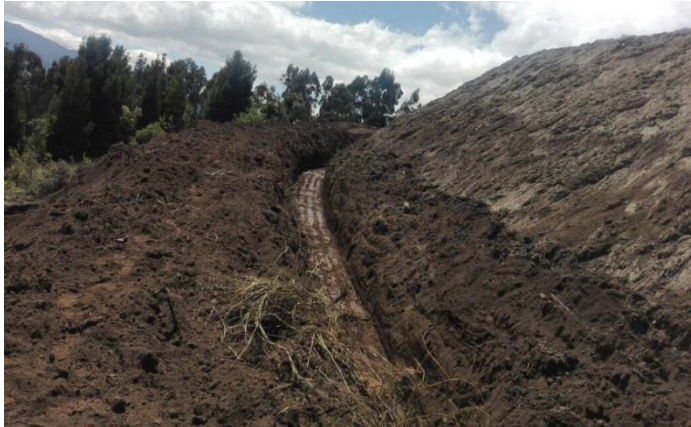
Foto 1: Construcción de cunetas
