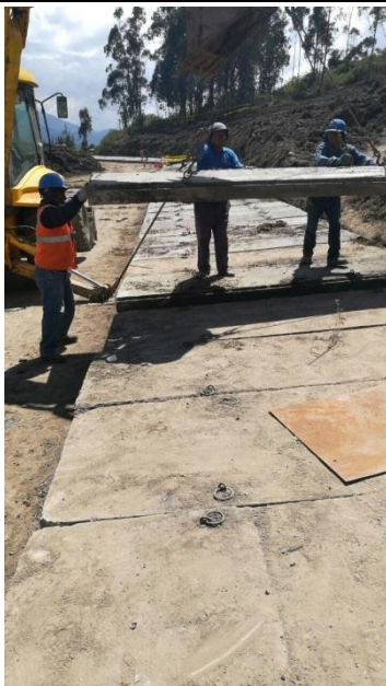
Foto 3: Cubierta completa del canal Pita - Puengasí
