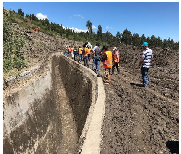
Foto 4: Desalojo de material deslizado en el canal El Pita
