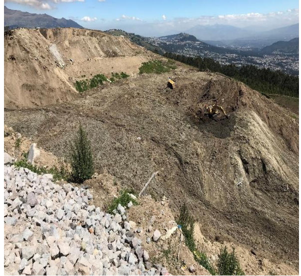
Foto 2: Vista del deslizamiento de la Plataforma Sur
