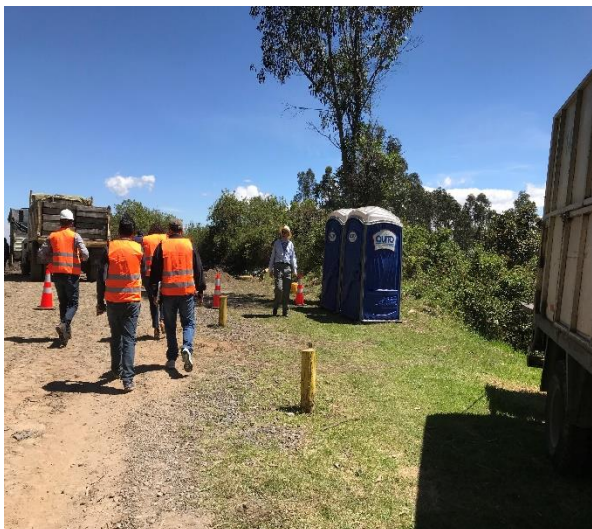
Foto 3: Instalación de baterías sanitarias portátiles para el personal que está trabajando
