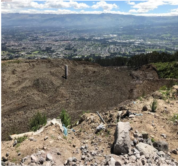
Foto 1: Vista del deslizamiento de la Plataforma Sur
