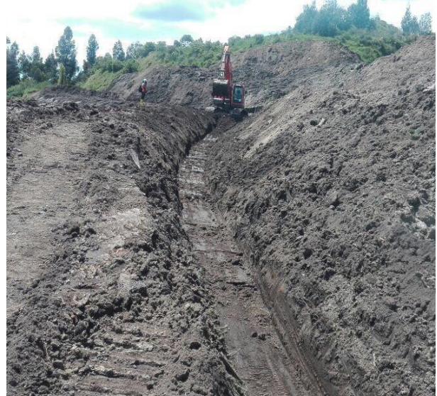
Foto 8: Retiro de material deslizado
