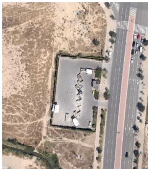
Figura 8.10. Planta de reciclaje, Zaragoza (España).
