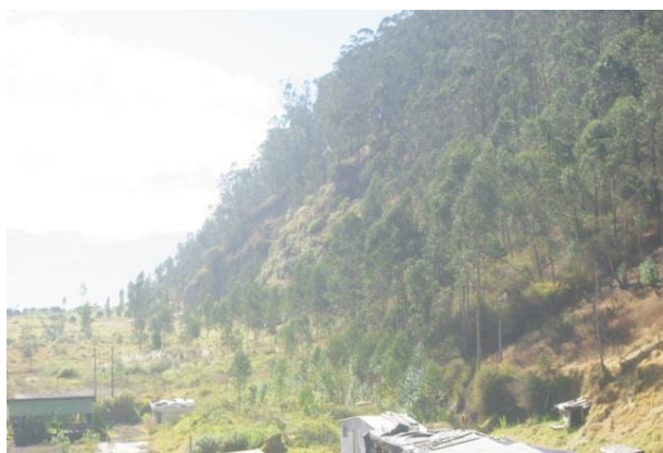
Foto 6.5. Vista panorámica talud derecho, antiguo botadero de Zámbriza.
