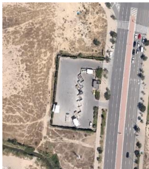
Figura 6.10. Planta de reciclaje, Zaragoza (España).
