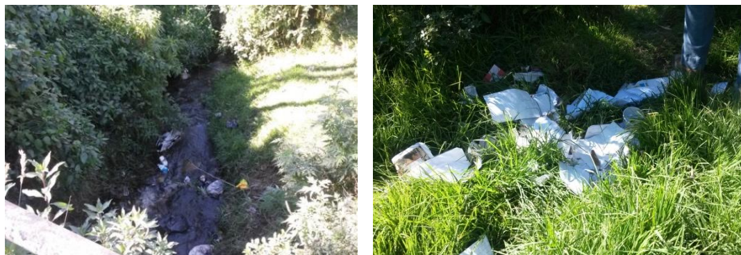
Foto 7.18. Quebrada Cevallos. Caudal de la quebrada (aguas servidas y naturales). Escombrera Qda. Cevallos.
