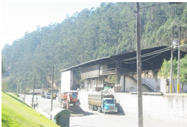
Foto 7.4. Estación de transferencia Norte, lado Oeste. Relleno sanitario Zábiza.
