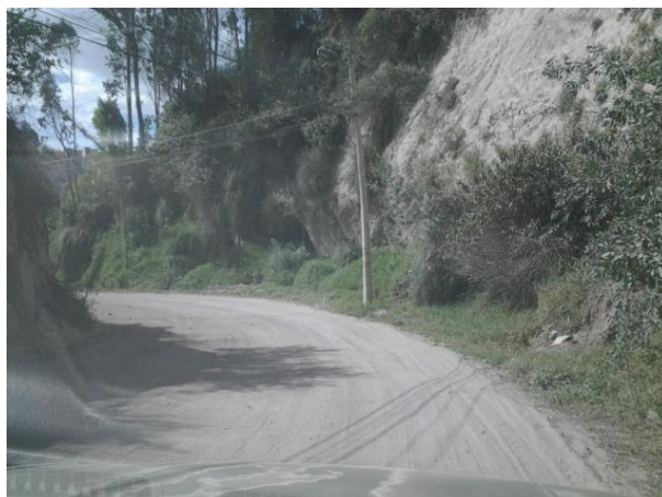
Foto 7.8. Vía de acceso, tercer orden. Ciudad Mitad del Mundo – Mina Sr. Córdova.
