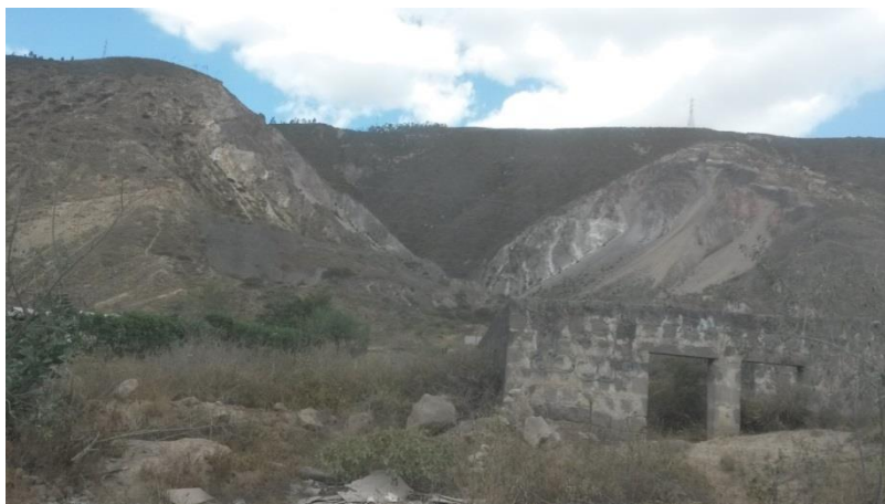
Foto 7.6. Vista panorámica. Escombrera Sr. Córdova.
