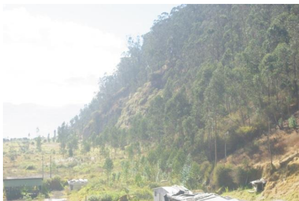
Foto 7.5. Vista panorámica talud derecho, lado Oeste. Relleno sanitario Zábiza.
