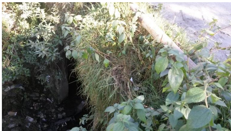
Foto 7.19. Puente tipo pórtico, parte baja. Qda. Cevallos.
