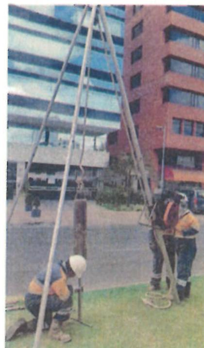
Foto 5: Ejecución del Sondeo PA-5
