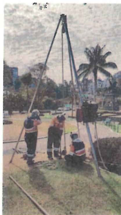
Foto 6: Ejecución del Sondeo PA-6
