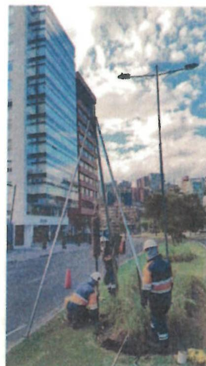
Foto 4: Ejecución del Sondeo PA-4
