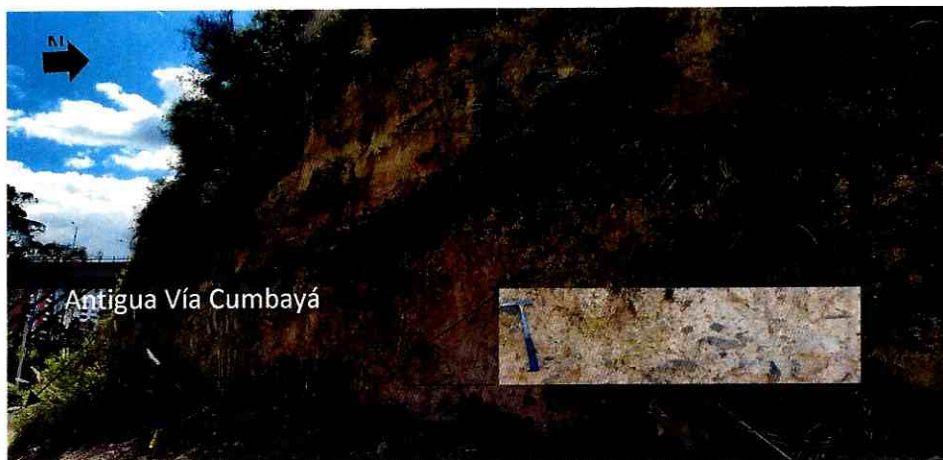
Foto. Abscisa 0+360, talud con inclinación de 80°, constituido por material volcanosedimentario consolidado.
