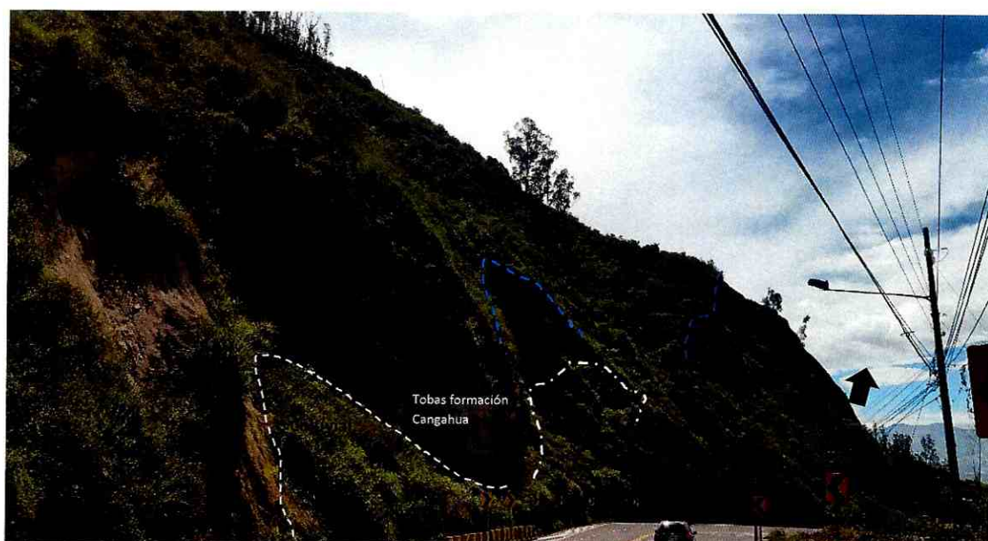
Foto: Abscisa 2+000 vista talud, constituido por material volcanosedimentario consolidado.
