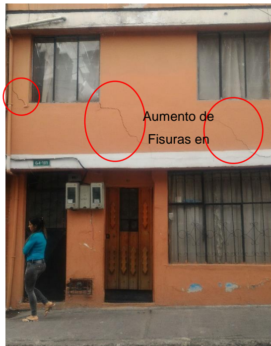
Fotografía 4. Tomada el 16 de marzo de 2018 – Calle Belda Fuente: LMC-PUCE
