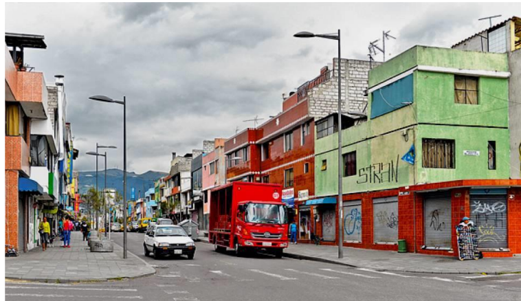
Fotografía 2. Viviendas modificadas para negocio
