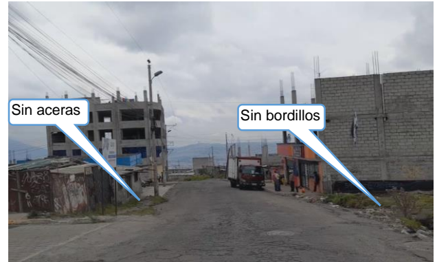
FOTO 6: "Sitios sin bordillos ni aceras, tramo asfaltado"
