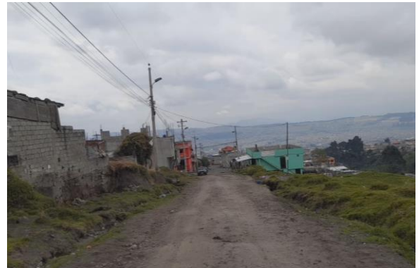
FOTO 8: "Tramo en tierra sin bordillos, calzada variable"
