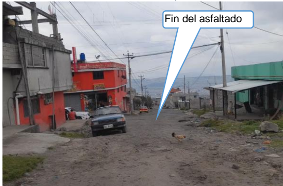
FOTO 7: "Fin del asfaltado, inicio en tierra"
