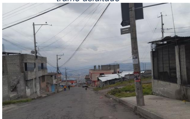
FOTO 3: "Bordillos y aceras existente, tramo asfaltado"
