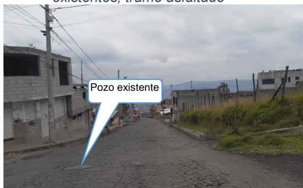
FOTO 4: "Pozos de alcantarillado existentes, tramo asfaltado"
