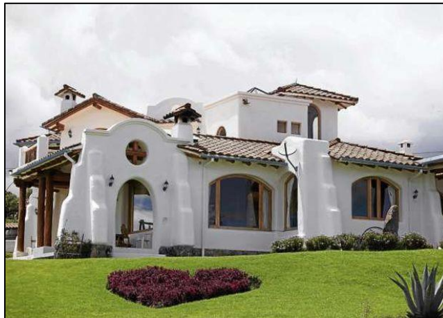
Ilustración 11 Imagen referencial de una edificación con estructura de adobe Fuente: http://icasasecologicas.com/bio-viviendas-la-casa-cueva-moderna/
