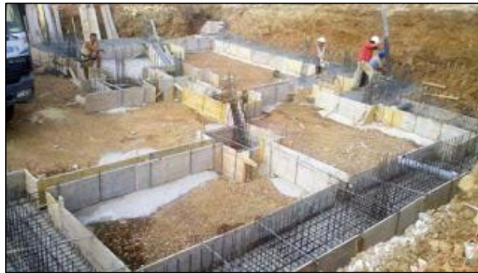
Ilustración 15 Ejemplo de una construcción “ en cimentación”
