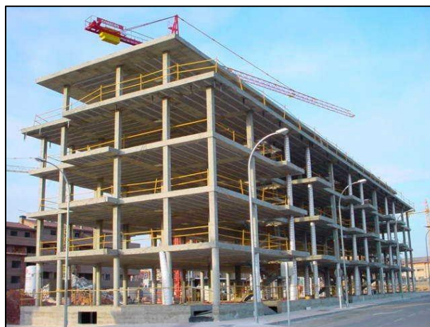
Imagen referencial de una edificación con estructura de hormigón armado Fuente: https://www.arqhys.com/construcciones/estructuras-hormigon-armado.html
