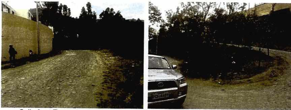
Calle 9na. Transversal en la primera curva de llegada a futuro acceso y curva en "U".
