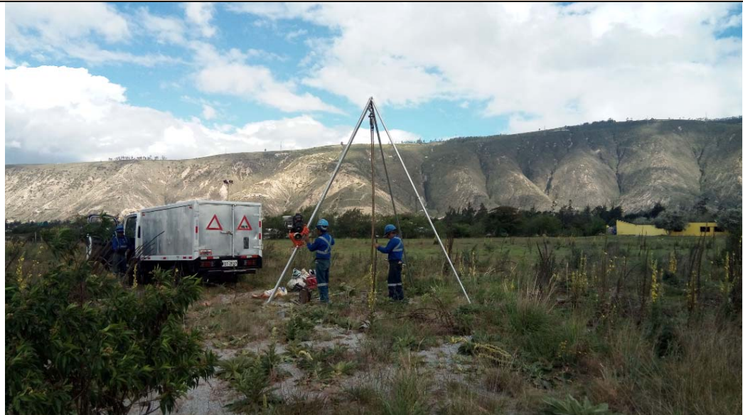
Foto 8. Pozo de perforación PP-8
