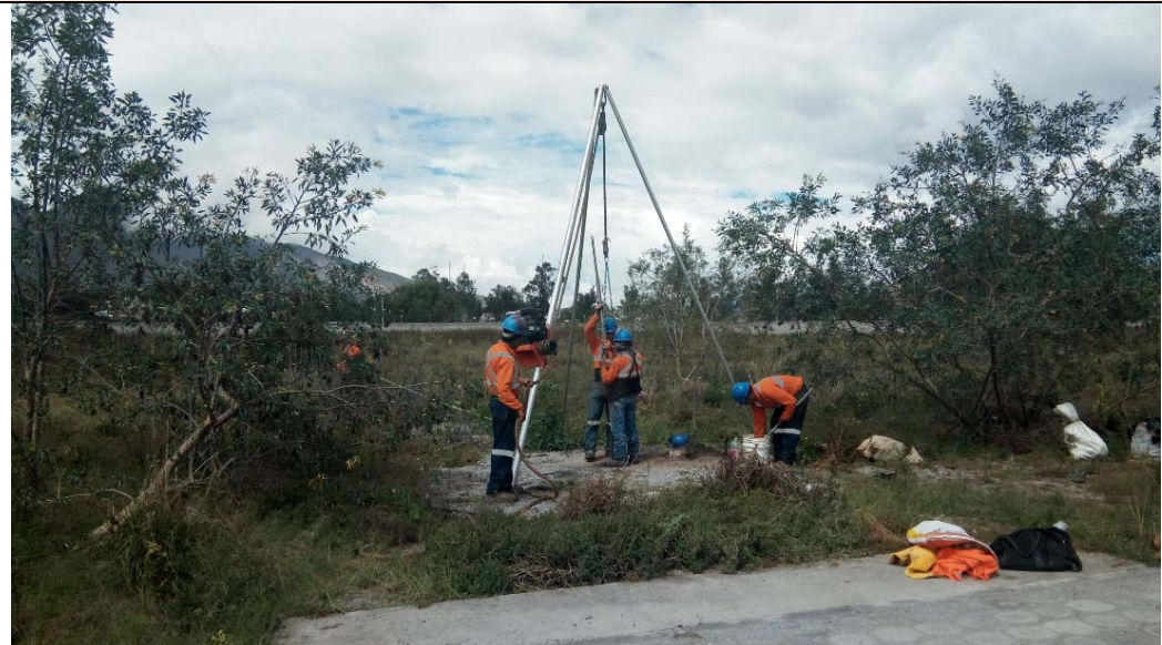
Foto 26. Pozo de perforación PP-26
