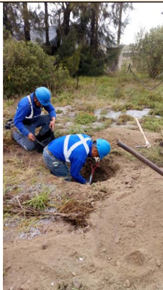
Foto 33. Pozo de perforación PCA-3
