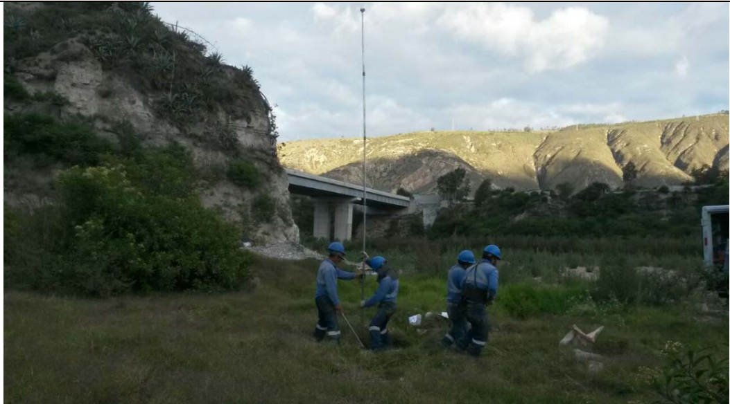
Foto 24. Pozo de perforación PP-24
