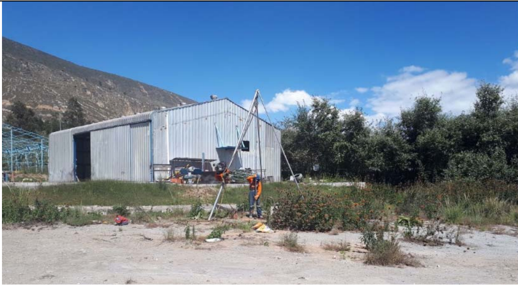
Foto 25. Pozo de perforación PP-25
