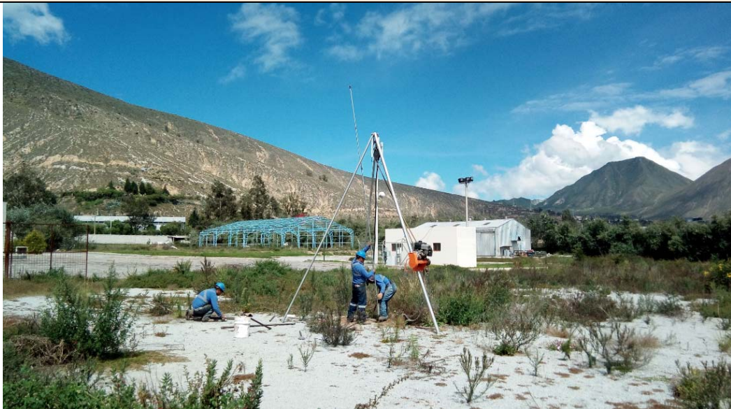
Foto 2. Pozo de perforación PP-2
