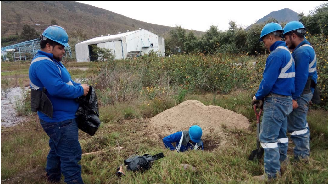
Foto 31. Pozo de perforación PCA-1
