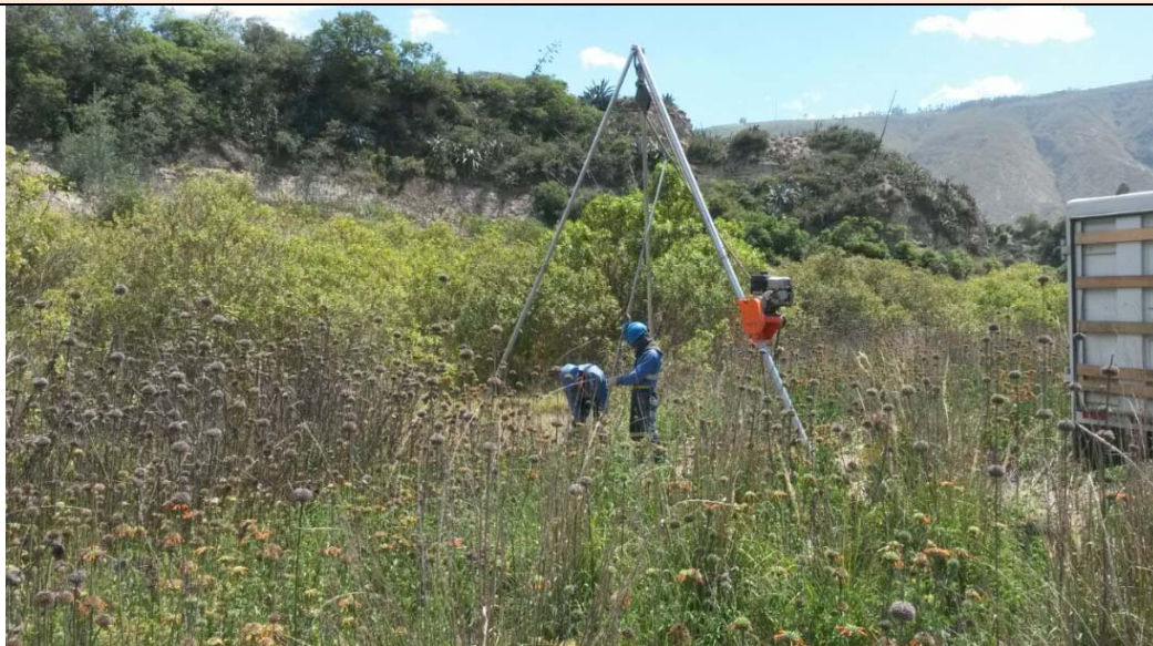
Foto 30. Pozo de perforación PP-30
