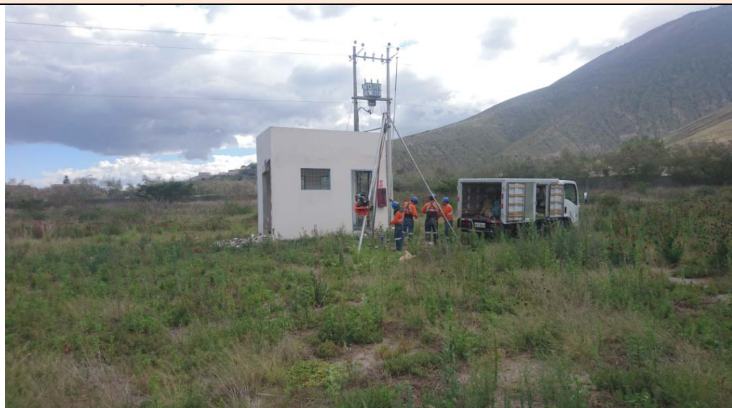
Foto 27. Pozo de perforación PP-27
