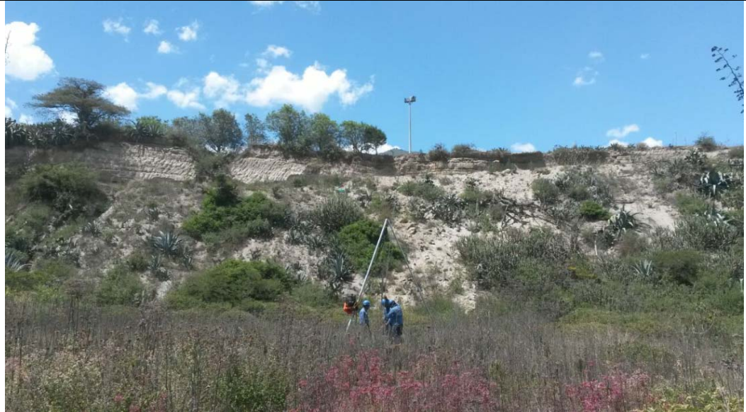
Foto 23. Pozo de perforación PP-23
