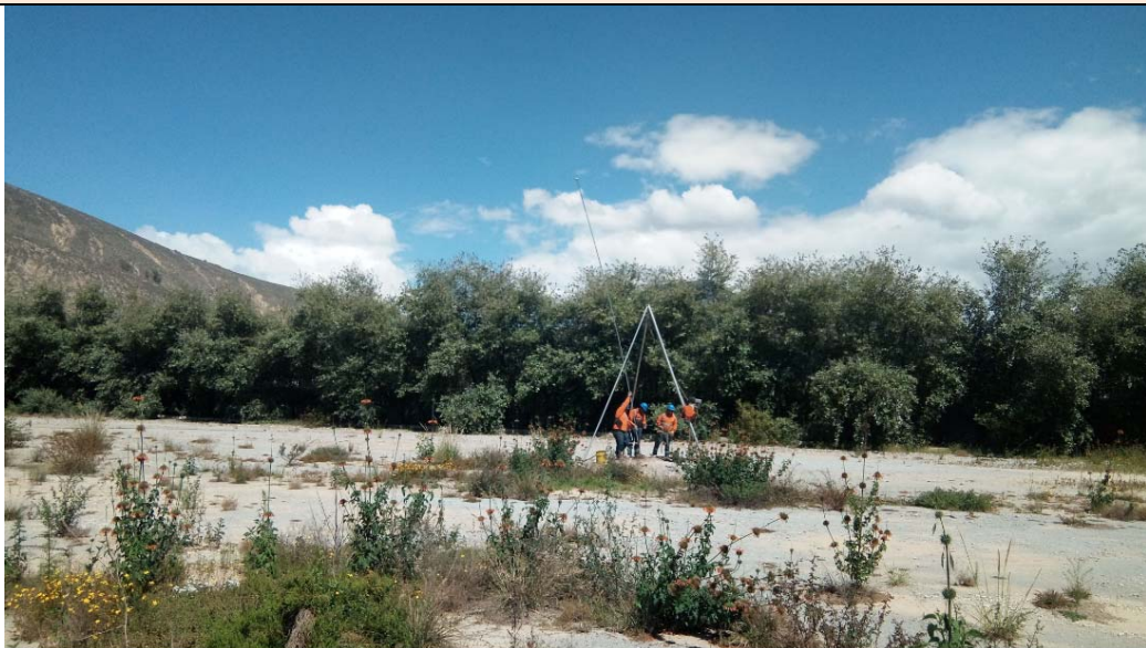
Foto 18. Pozo de perforación PP-18
