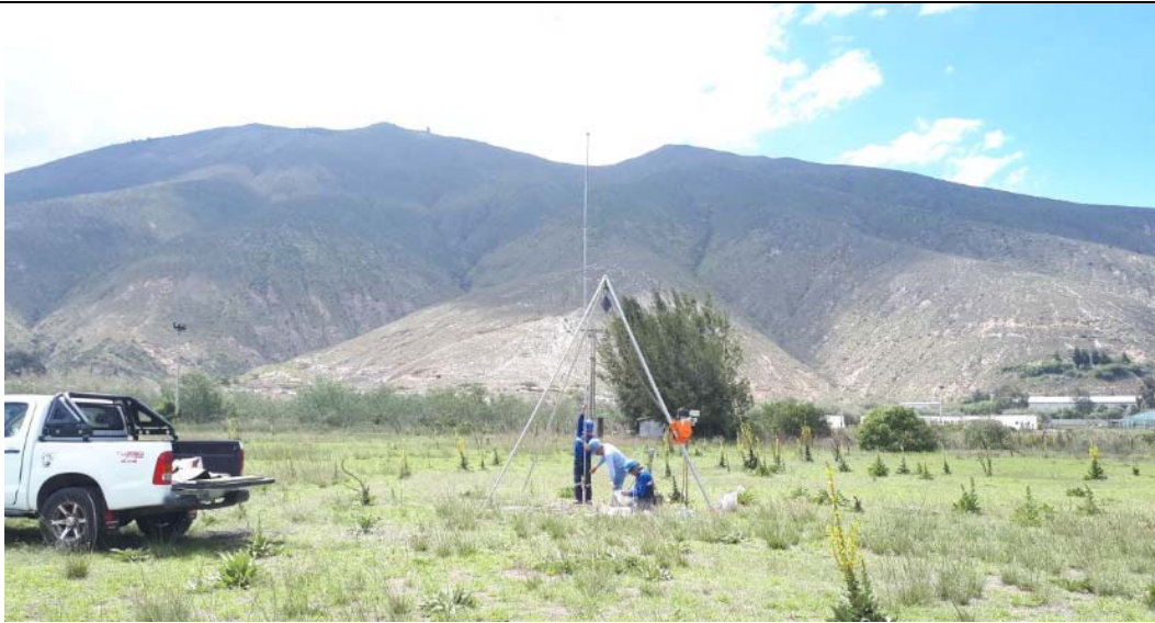
Foto 22. Pozo de perforación PP-22
