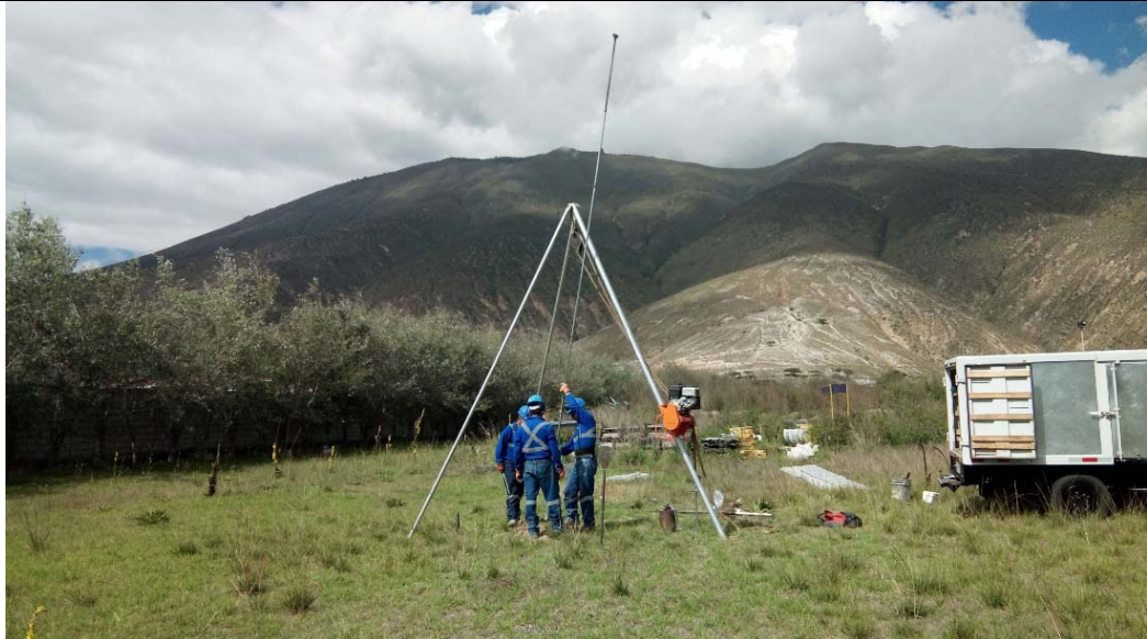
Foto 14. Pozo de perforación PP-14
