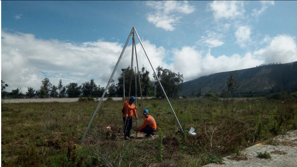
Foto 5. Pozo de perforación PP-5
