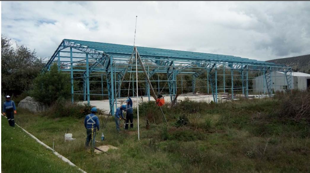
Foto 1. Pozo de perforación PP-1
