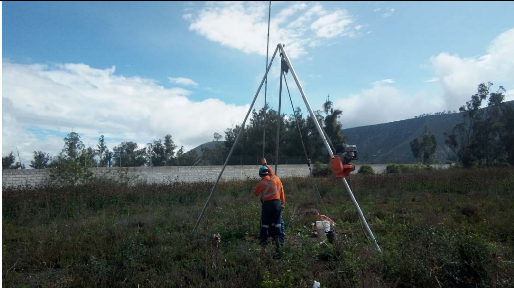
Foto 19. Pozo de perforación PP-19
