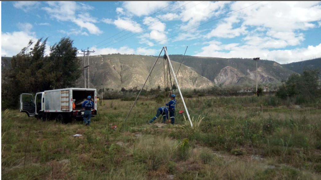
Foto 13. Pozo de perforación PP-13
