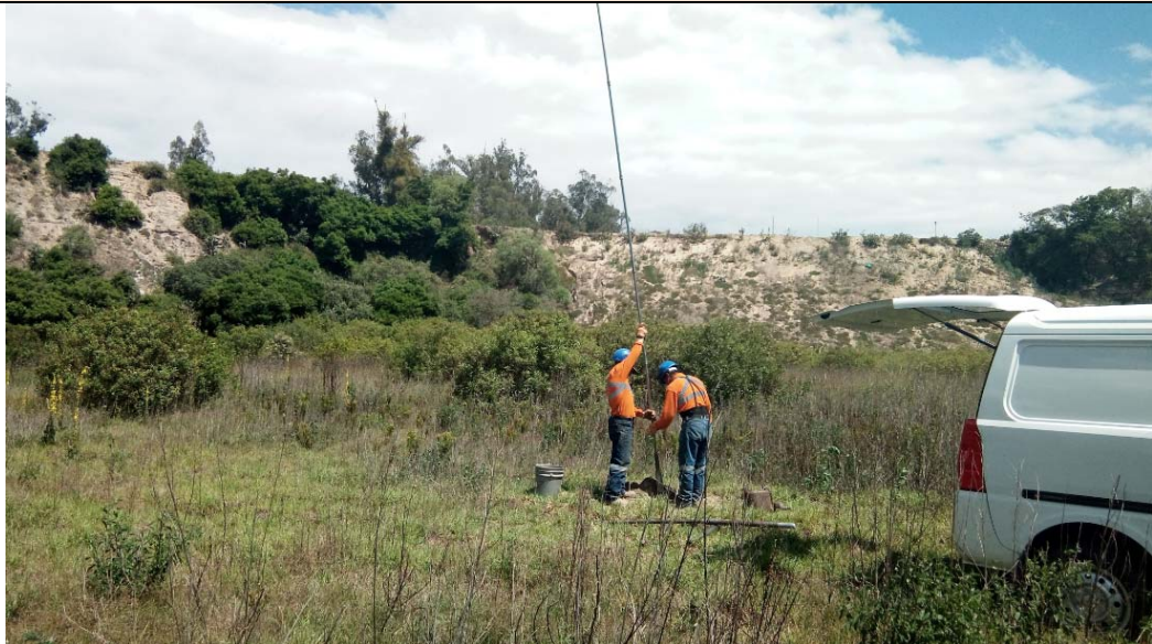
Foto 15. Pozo de perforación PP-15
