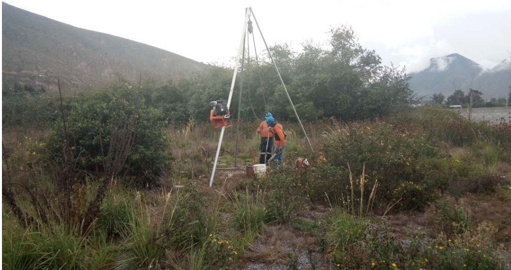
Foto 4. Pozo de perforación PP-4
