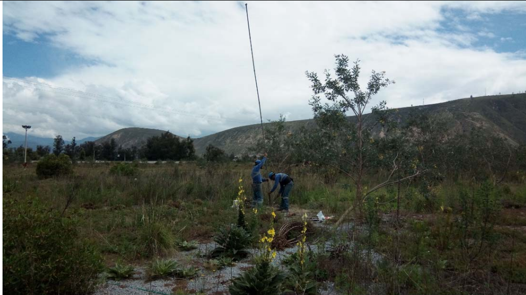
Foto 11. Pozo de perforación PP-11
