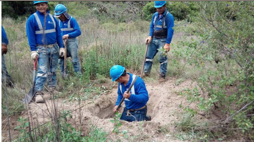
Foto 35. Pozo de perforación PCA-5
