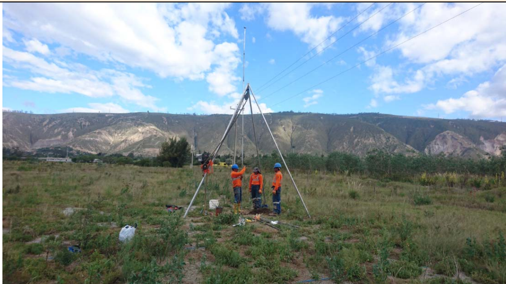
Foto 21. Pozo de perforación PP-21
