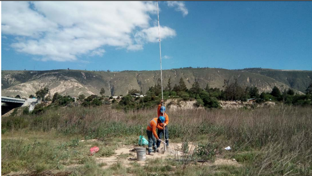
Foto 16. Pozo de perforación PP-16
