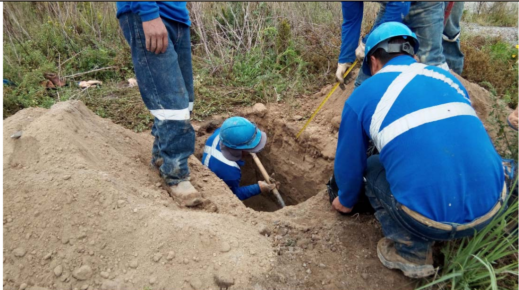
Foto 32. Pozo de perforación PCA-2
