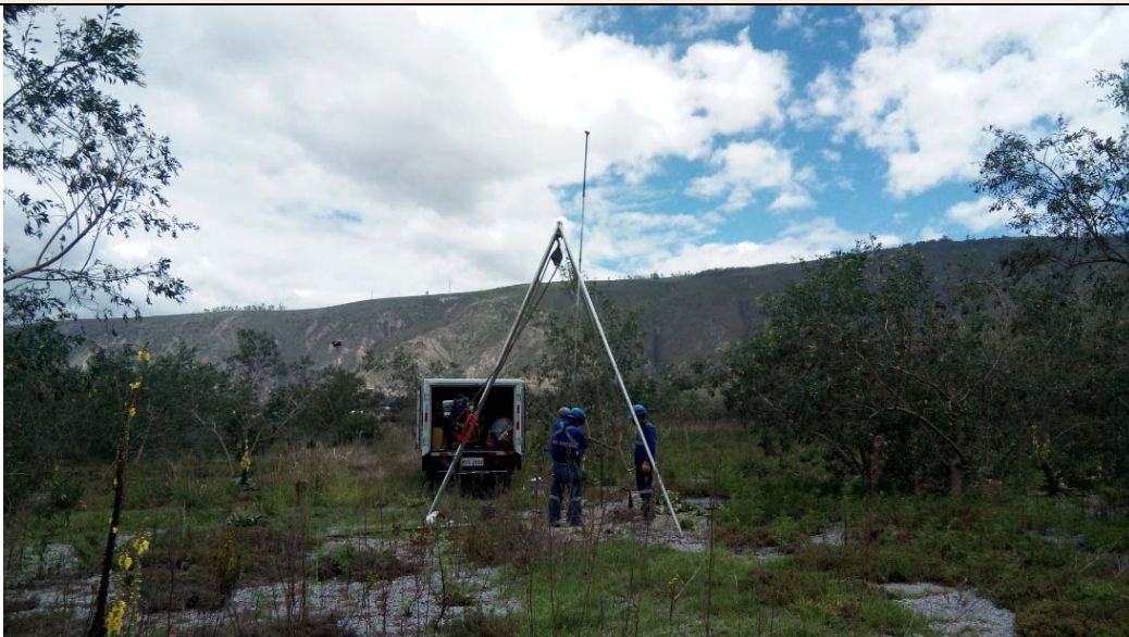
Foto 12. Pozo de perforación PP-12
