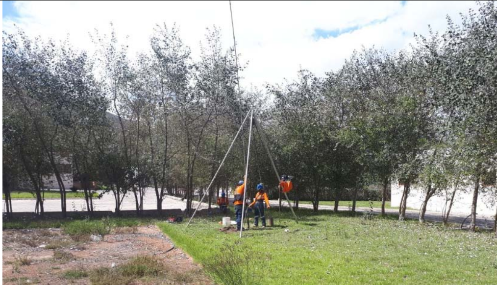
Foto 17. Pozo de perforación PP-17
