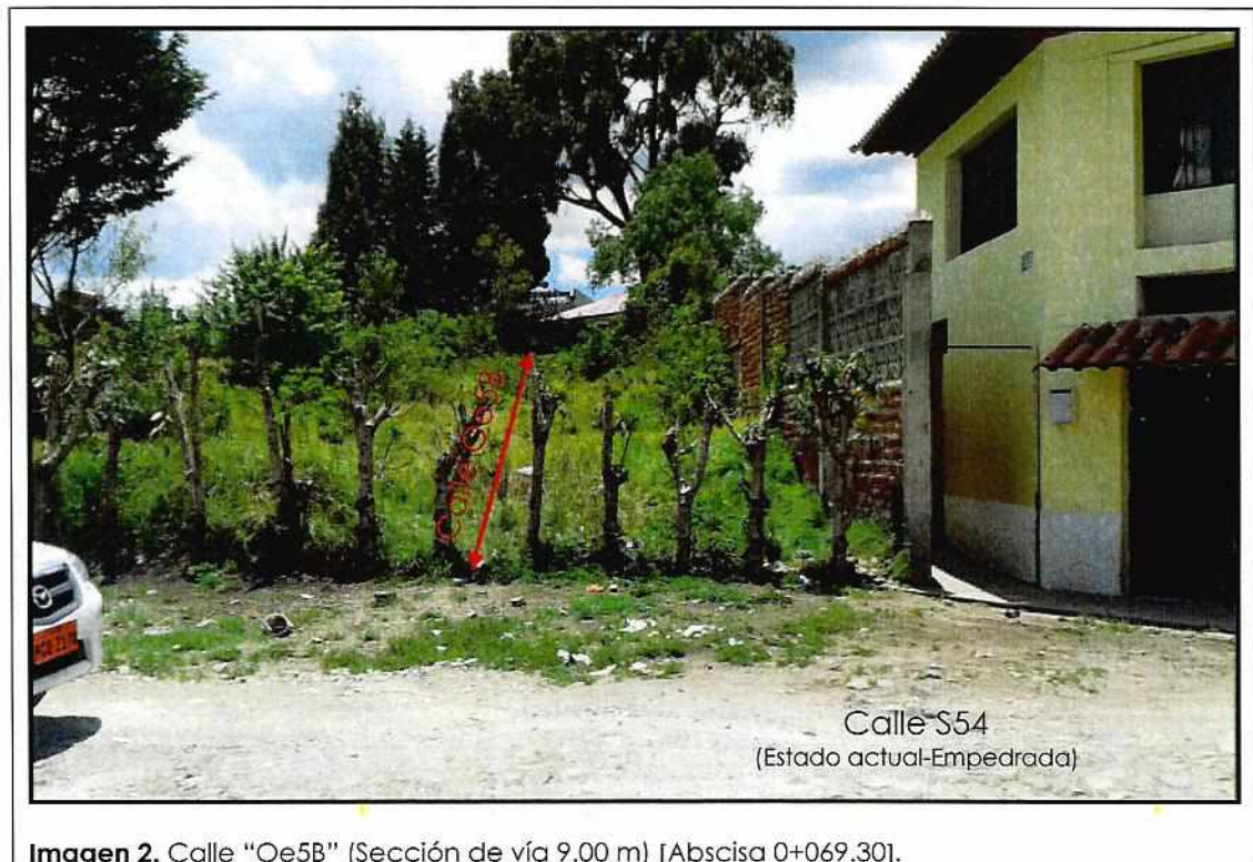
Imagen 2. Calle "Oe5B" (Sección de vía 9.00 m) [Abscisa 0+069.30].
