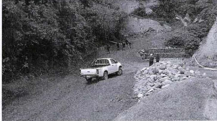
Foto 4: Vista posterior de la quebrada Pucará rellena, muro de contención y camino que conduce al farallón
