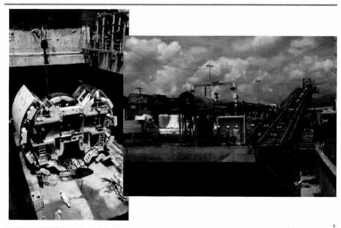
SEÑOR ALCALDE: Lo que se ve ahí es la tuneladora, ahí está ensamblada ya la tuneladora Luz de América que se ve en el fondo.
